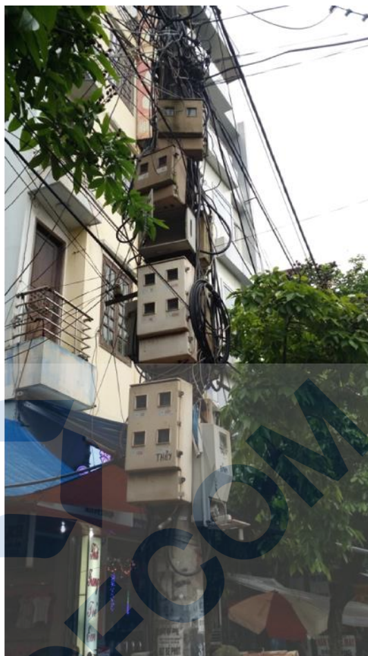
图 10 越南电能表安装现场图
